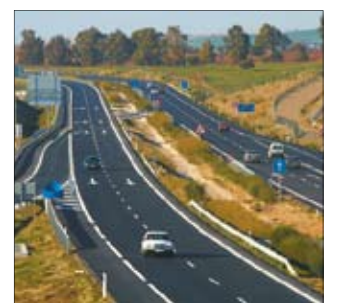
La autovía A-381 en Jerez de la Frontera. JUNTA ANDALUCÍA
