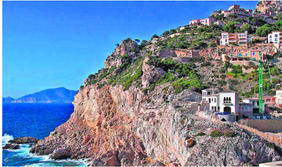
Construcciones recientes en una zona protegida de la costa de Andratx (Mallorca).
